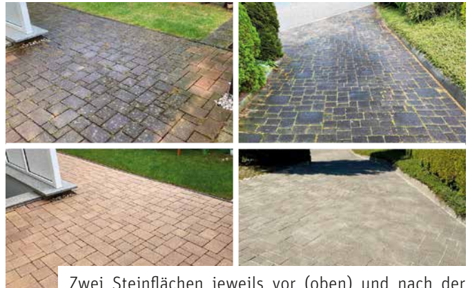
Zwei Steinflächen jeweils vor (oben) und nach der Sanierung (unten) (Foto: MH Stone)
